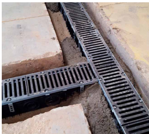
T-kopplingsfunktion möjliggör förgrening av rännan.
